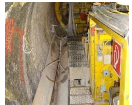
Ausbruch des Schrägschachtes mit Tunnelbohrmaschine (TBM Typ Wirth \varnothing 3.00 m mit Rückfallsicherung)
