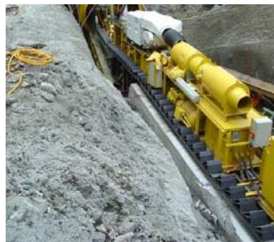
Ausbruch des Schrägschachtes mit Tunnelbohrmaschine (TBM Typ Wirth \varnothing 3.00 m mit Rückfallsicherung)
