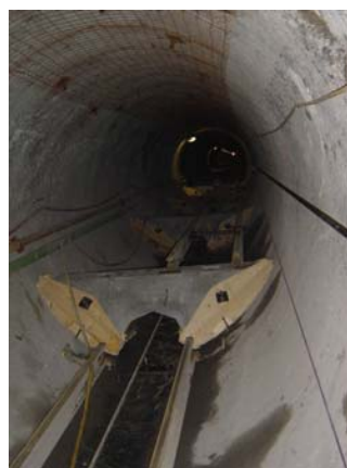
Montage der Beton-Fertigelemente für Rohraufleger
