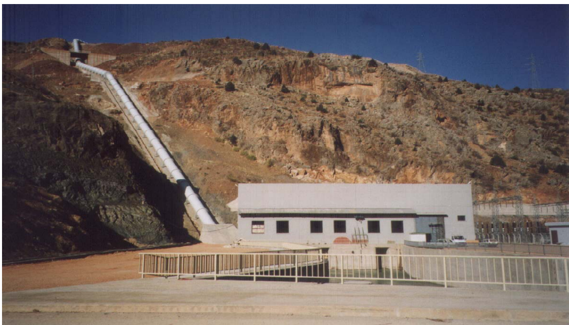
Kraftwerk und Druckleitung, Februar 1999
