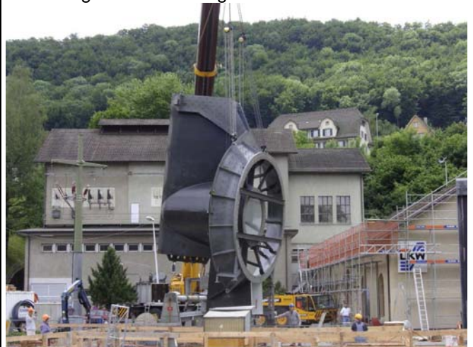
KW Kappelerhof Montage des Turbinengehäuses
