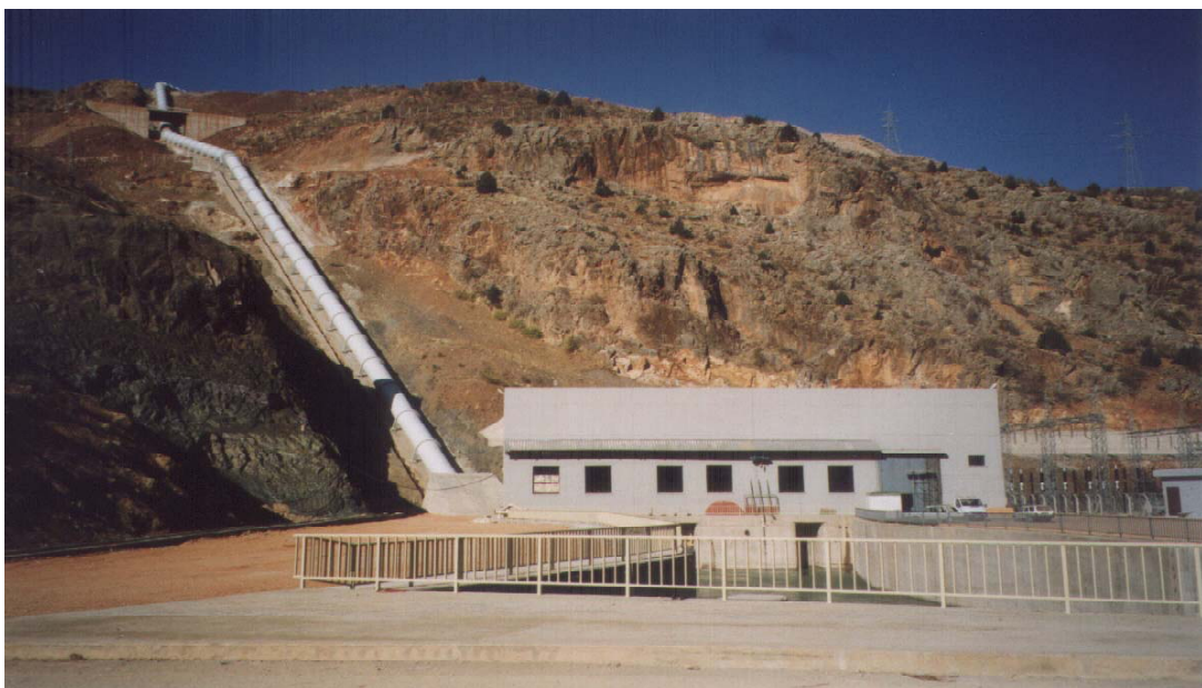
Centrale hydroélectrique et conduite forcée - Février 1999
