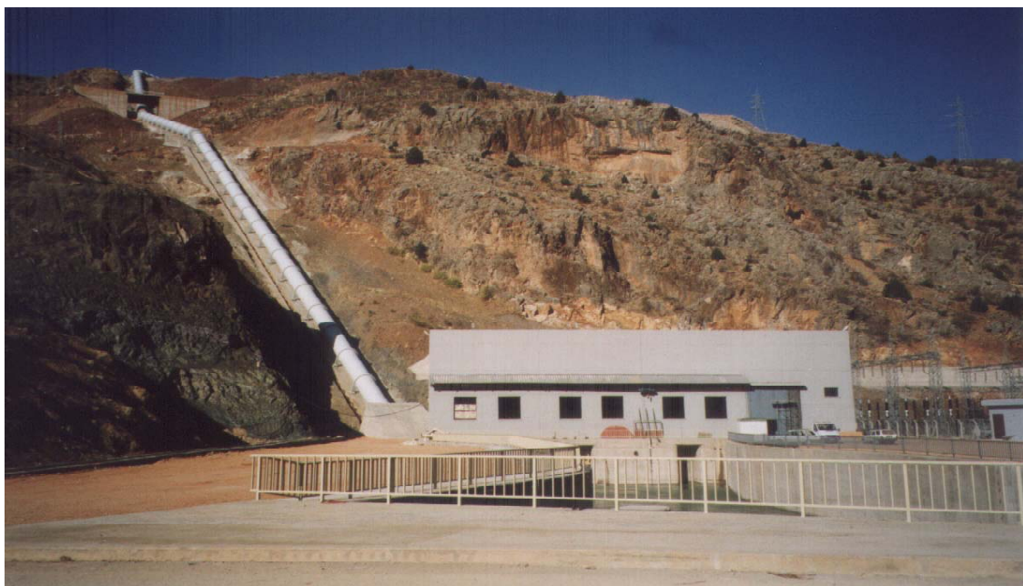
Centrale e condotta forzata, febbraio 1999
