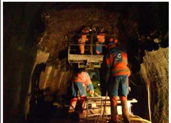
Arbeiten in Lockergestein
