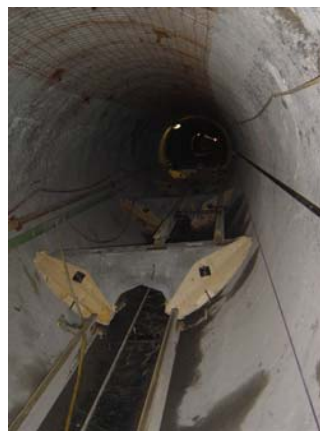
Montage der Beton-Fertigelemente für Rohraufleger
