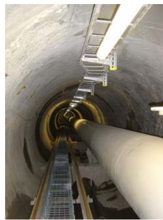
Fertig montiertes Druckrohr im Schrägschacht mit Schiene des Inspektionsaufzuges
