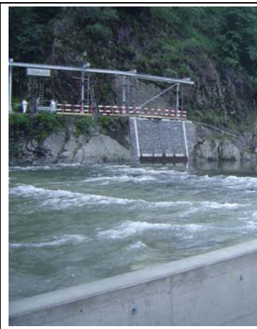
Wasserfassung mit Einlaufbauwerk
