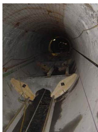
Montage d'éléments en béton pour le support de tuyaux
