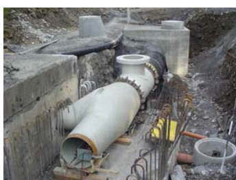
Montage d'éléments en béton pour le support de tuyaux
