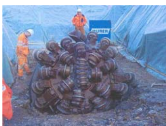
Arrivé du tunnelier à Bannalp
