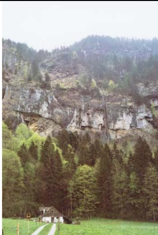
Chute entre Bannalp et Fellboden de la conduite forcée existante
