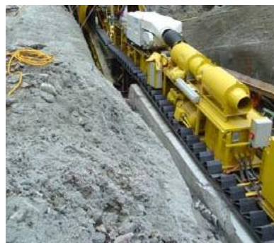
Excavation du puits incliné avec le tunnelier (Tunnelier Type Wirth \varnothing 3.00 m)
