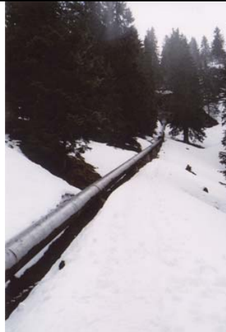
Conduite forcée existante à ciel ouvert ( D = 0.55 \text{ m} )
