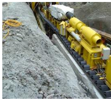
Scavo del pozzo inclinato con fresa (TBM tipo Wirth \varnothing 3.00 m con sicurezza per l'arretramento)
