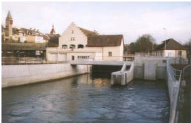
Vista dell'impianto, lato di valle
