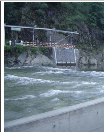
Presa d'acqua con costruzione d'entrata
